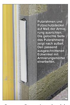
**Baulicher Brandschutz:** Ist eine Kapselung des LUNOtherm-S notwendig, muss diese entsprechend der Vorgaben ausgeführt werden, bevor die umlaufende Dämmung herangearbeitet wird. **Montage mit Überdämmung:** Das LUNOtherm-S sitzt direkt auf der Wand, daher liegt der Ausschnitt für die Lüftungsöffnung des LUNOtherms dichter an der Rohbauwand und weiter entfernt von der Laibungskante. Die Arbeitsschritte ändern sich daher nur geringfügig.
