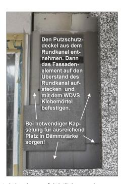
Das angepasste LUNOtherm-S wird mit dem Klebe- und Armierungsmörtel des bauaufsichtlich zugelassenen WDVS auf der Unterdämmung oder bei Überdämmung direkt auf der Wand befestigt (siehe auch Hinweis zum Kleber/Mörtel auf Seite 1).
