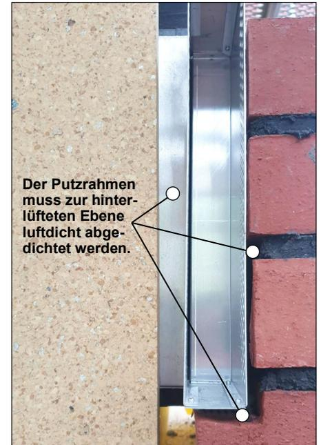
Wird das LUNOtherm in eine verblendete Fassade eingebaut, ist einer der wichtigsten Punkte die Trennung der Frischluftversorgung der Innenräume von der Hinterlüftung der Verblendung. Die entsprechenden Hinweise dazu finden sich in den Detailbildern.
