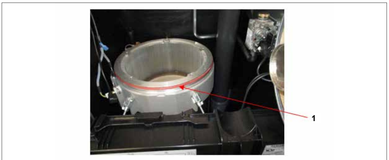
Abb. 5.21 Dichtring Brennkammerdeckel
