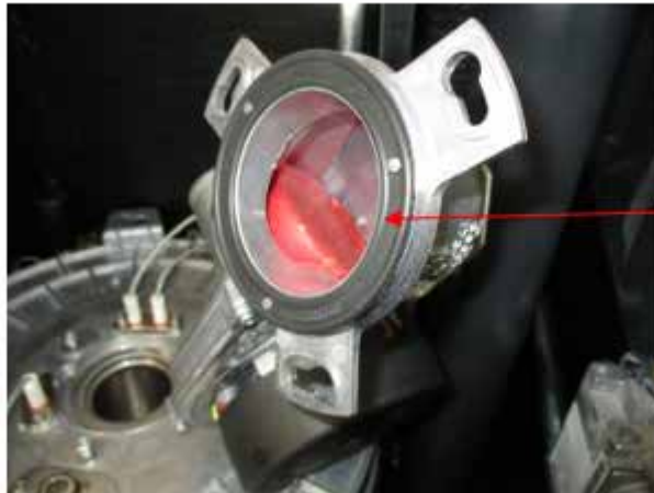
Abb. 5.9 Brennerdichtung tauschen
