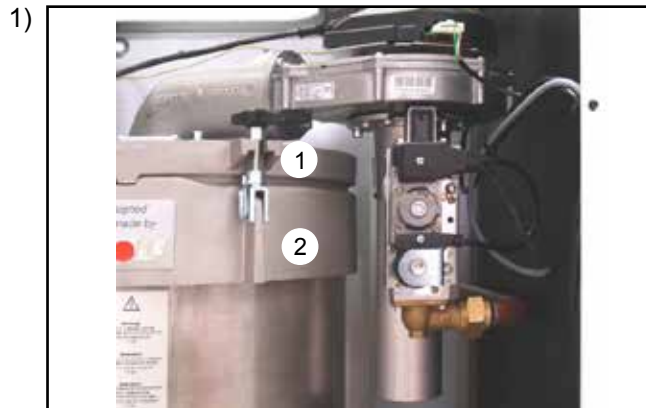
Stecker ①② abziehen (vorher Kreuzschlitzschrauben lösen)
