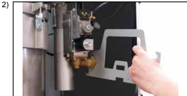
Verschraubung Gasanschluss am Gaskombiventil lösen
