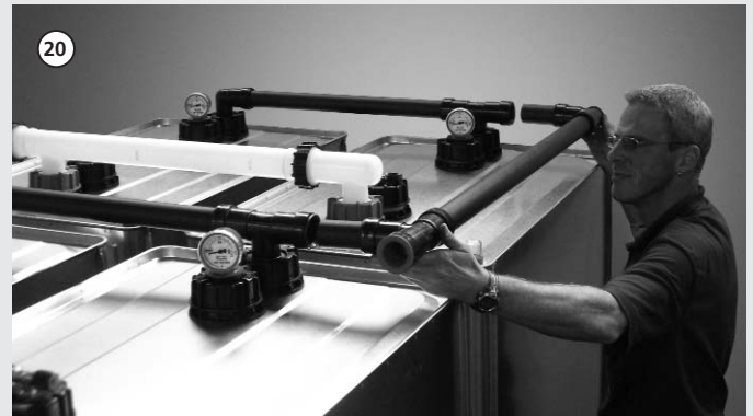
...in die freien Enden der Entlüftungsleitung der Tankreihen einstecken. ...insert into the free ends of the ventilation line of the tank rows. ...l'insérer dans l'extrémité libre de la conduite de purge des séries de réservoirs. ...in de vrije uiteinden van de ontluchttingsleiding van de tankrijen steken.
