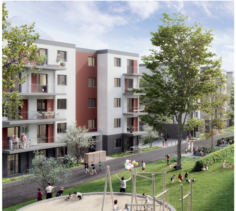
140 Wohnungen werden auf Basis von Biomasse, Photovoltaik und Kraft-Wärme-Kopplung mit Energie versorgt.
