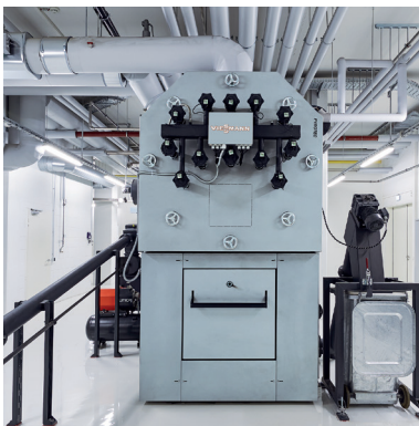
Holzpelletkessel Vitoflex 300-UF mit einem Wärmeleistungsbereich von 300 bis 950 kW
