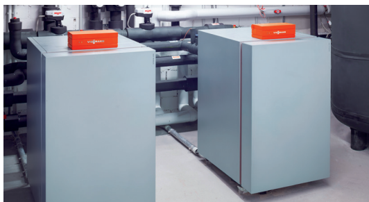
Die Sole/Wasser-Wärmepumpen Vitocal 300-G erbringen jeweils eine Leistung von 12,6 kW.
