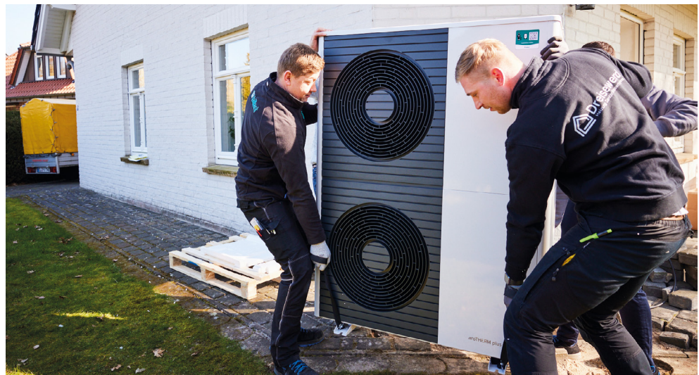
Abb. 10: Aufstellung Außeneinheit, Quelle: Vaillant
