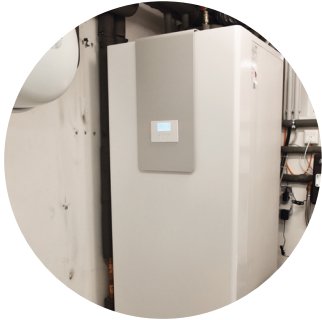
Abb. 9: Kompakte Hydraulikeinheit mit eingebautem Pufferspeicher, Warmwasserspeicher und Regelung, Quelle: STIEBEL ELTRON
