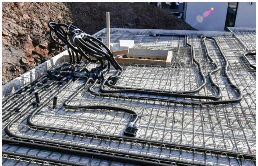
Verlegung von Rundkanälen R75 in die Betondecke
