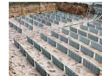
Verlegebeispiel im Komplett-Aushub (auch im Grabenaushub möglich)
