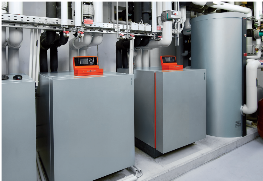
Sole/Wasser-Wärmepumpe Vitocal 350-G Heizleistung einstufig: 20,5 bis 42,3 kW, zweistufig: 41,0 bis 84,6 kW
