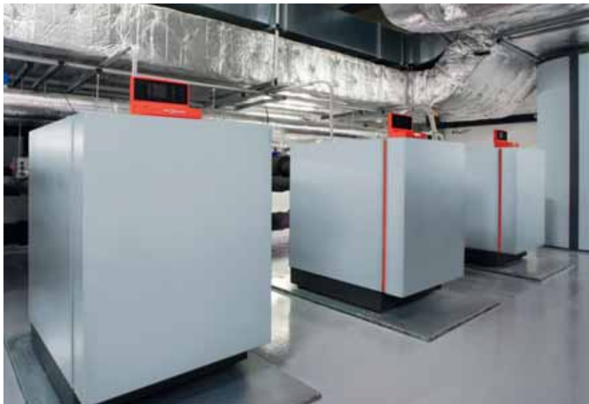
Sole/Wasser-Wärmepumpe Vitocal 300-G Heizleistung einstufig: 21,2 bis 42,8 kW, zweistufig: 42,4 bis 85,6 kW, maximal 428 kW (als Kaskade)
