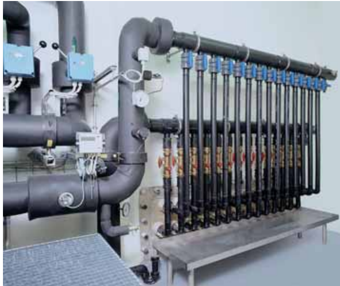
Erdsondenverteiler
