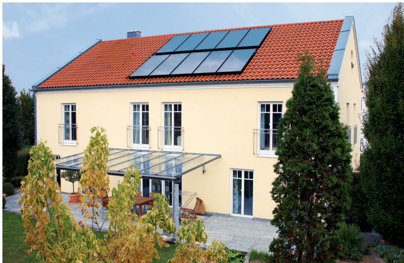
Vitosol 200-FM Zweifamilienhaus Geisenfeld
