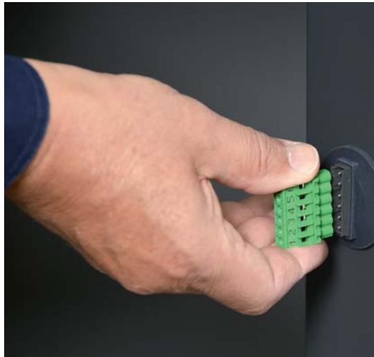
Plug & Play-Steckverbindung für die meistgenutzten elektrischen Anschlüsse (hier beim Vitodens 333-F)
