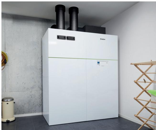
Die platzsparende und komplett innen aufgestellte Luft/Wasser-Wärmepumpe recoCOMPACT exclusive ist die All-in-one-Lösung für Heizung, Lüftung und Warmwasser. Das System nutzt die kostenlose Umweltenergie besonders effizient. Noch zukunftsweisender ist die Kombination mit einer Photovoltaikanlage. So können Sie den Strom, den die Wärmepumpe für ihren Betrieb benötigt, selbst erzeugen. Die recoCOMPACT exclusive eignet sich für den Einsatz im Einfamilienhaus Neubau.
