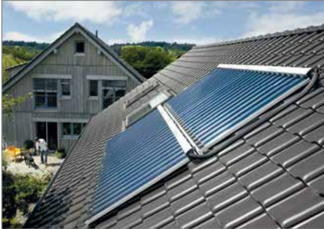
Abb 21: Nutzung von Solarenergie durch Röhrenkollektoren
