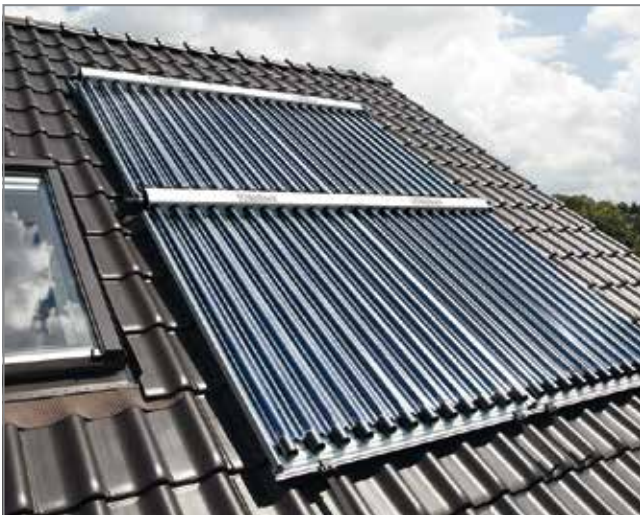
Abb 135: Aufdachmontage mit vertikalen Röhrenkollektoren
