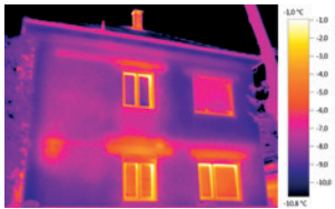
Wärmebild mit testo ScaleAssist
