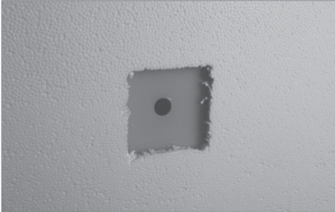
1. Beschädigte Stelle freilegen
