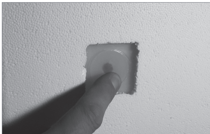
6. Applicare il dischetto immediatamente sul foro, esercitando una breve pressione
