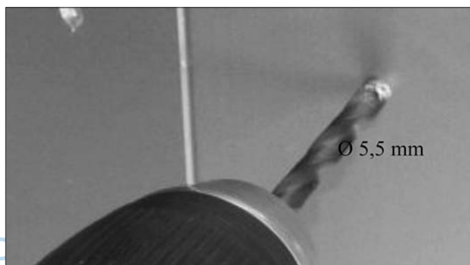
4. Löcher bohren, dazu das Duschpaneel aufklappen.
