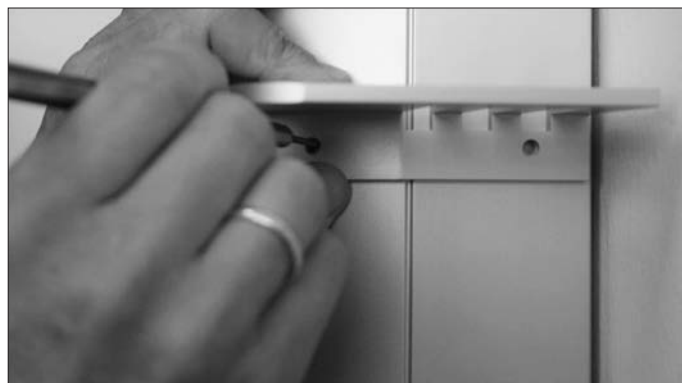
2. Bohrlöcher anzeichnen.
