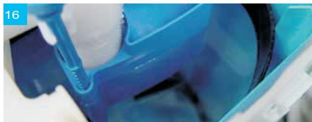
Wasserstand auf Unterkante Spannring
