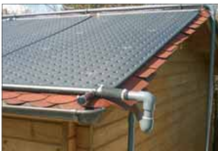
Schrägdachmontage
