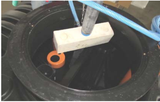
Einsetzen des Belüfterfuß im SBR-Becken
