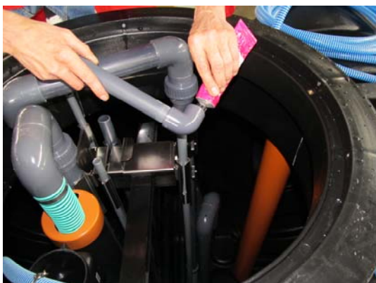
Rohrbogen an der Schlammrückführung mit Tangitkleber verkleben, so dass dieser in das Vorklärbecken führt
