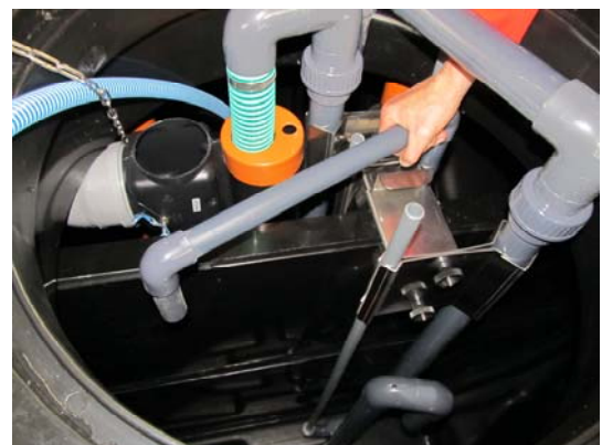
Rohrbogen an der Schlammrückführung mit Tangitkleber verkleben, so dass dieser in das Vorklärbecken führt
