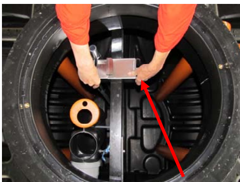
Befestigungsschraube handfest anziehen
