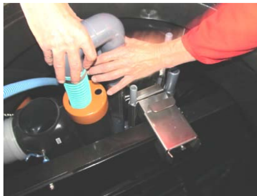
Halteklammer ausrichten und Ablaufschlauch im Überlaufsiphon einsetzen
