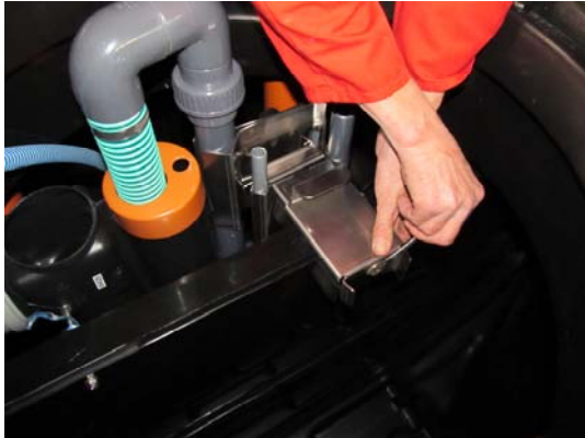
Schraube an der Halteklammer festziehen
