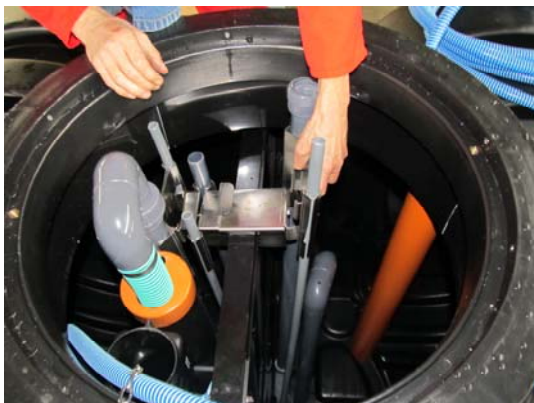
Dossierpumpe im Vorklärbecken in Halteklammer einsetzen
