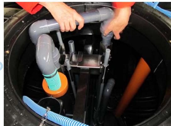
Rohrbogen so montieren, dass dieser in das SBR-Becken führt
