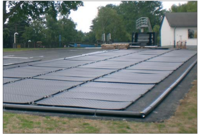
Montage auf Freifläche
