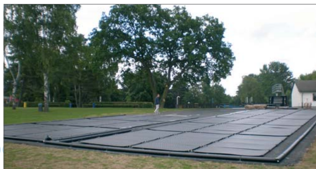
Freiflächenmontage Schwimmbad Wehrheim
