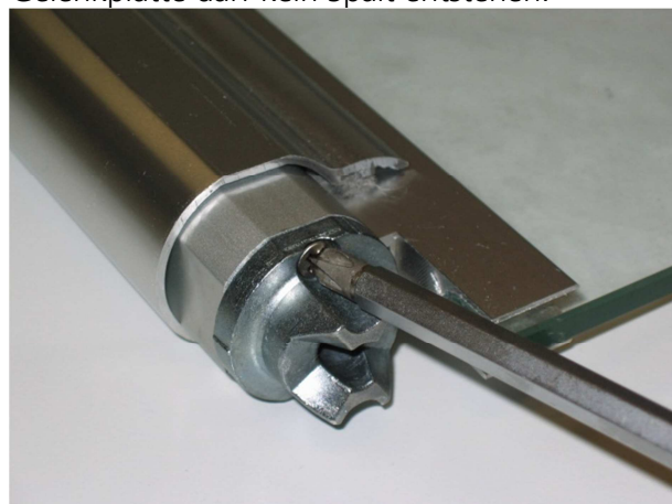
6) neue Drehplatte am Türflügel unten montieren
