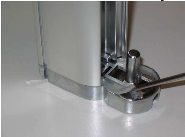
3) Gelenkplatte unten reinigen und Silikonreste komplett entfernen.
