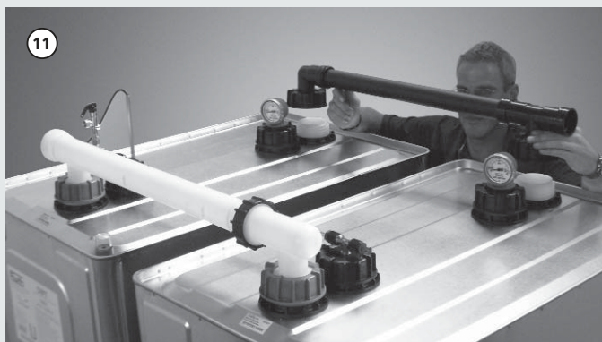
Nächste Tankreihe auf Fußgestell aufsetzen. Tank-Mittenabstand zwischen den Reihen von 780 mm bei DWT 620 (1150 mm bei DWT 1000) wird durch beiliegende Abstandhalter vorgegeben. Füllstanduhren in die Buchse auf jedem 3. Tankstutzen einschrauben. Install the next tank row onto mounting frame. Tank centre-to-centre distances between the rows of 780 mm with DWT 620 (1150 mm with DWT 1000) are permitted with accompanying spacers. Screw fill-level meter into the bushing on every 3rd tank connection. Poser le réservoir suivant sur le montant à pieds. L'entraxe de réservoirs entre les séries de 780 mm pour DWT 620 (1150 mm pour DWT 1000) défini grâce à la pièce d'écartement ci-jointe. Visser les indicateurs de niveau dans la douille sur chaque 3ème raccord de réservoir. Volgende tankrij op onderstel plaatsen. Tank-middenafstand tussen de rijen van 780 mm bij DWT 620 (1150 mm bij DWT 1000) wordt door meegeleverde afstandhouders geregeld. Vulstandmeters in de bus van elke 3e tanksok schroeven.
