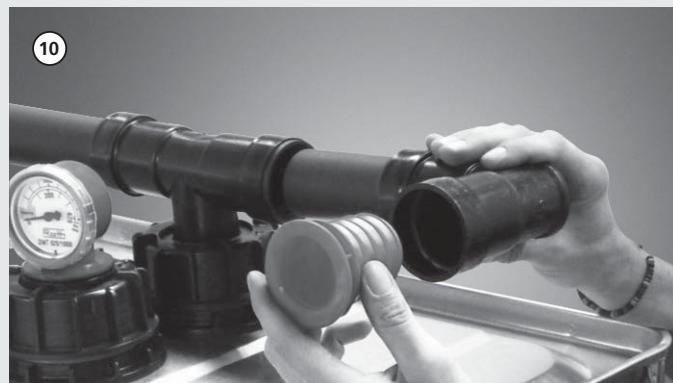
Nur bei einreihiger Aufstellung! Winkel-Sammelrohr und Anschlagdichtung für Entlüftungsanschluss montieren. Die einreihige Tankanlage ist nun fertig montiert. Only with single-row installation! Install angled manifold and compression seal for ventilation connection. The single-row tank system is now completely installed. Uniquement pour une installation en une série ! Monter le tube collecteur coudé et le joint à butée pour le raccord de purge. Le montage de l'installation de réservoirs en une série est maintenant terminé. Alleen bij opstelling in één rij! Hoek-verzamelbuis en aanslagpakking voor ont-luchtingsaansluiting monteren. De montage van de enkelrij tankopstelling is nu klaar.
