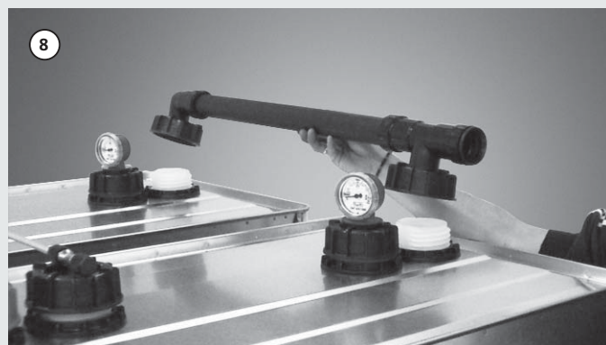
Entlüftungsleitung auf die 4. Stutzenreihe aufsetzen. Install the ventilation line on the 4th connection row. Poser la conduite de purge sur la 4ème série de raccord. Ontluchtingsleiding op de 4e sokrij zetten.
