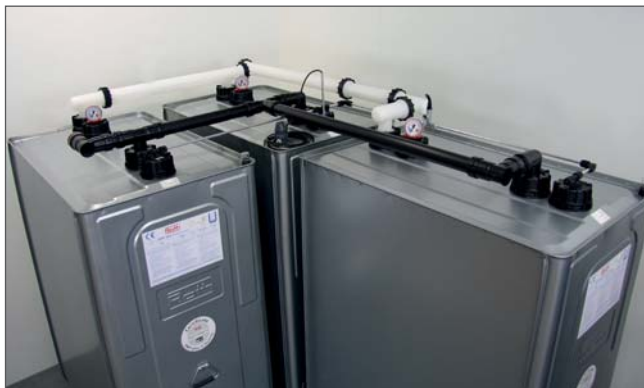
7. Fertig montierte Winkel L-Aufstellung.
