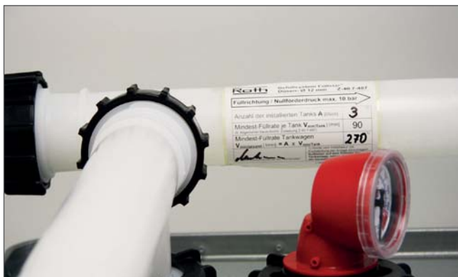
8. Mitgelieferte Zulassungsaufkleber ausfüllen und an Füllleitung sowie Tank (siehe 7.) anbringen.
