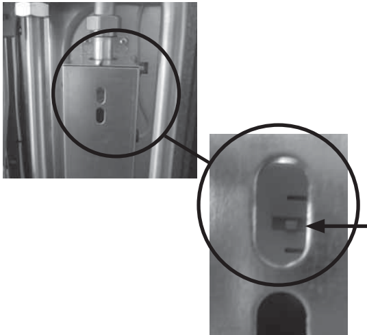
Sicherheitstempurbegrenzer und Reset-Knopf (Pfeil)
