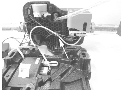
Abb. 8: Verbindungskabel in den Kabelbinder einsetzen
