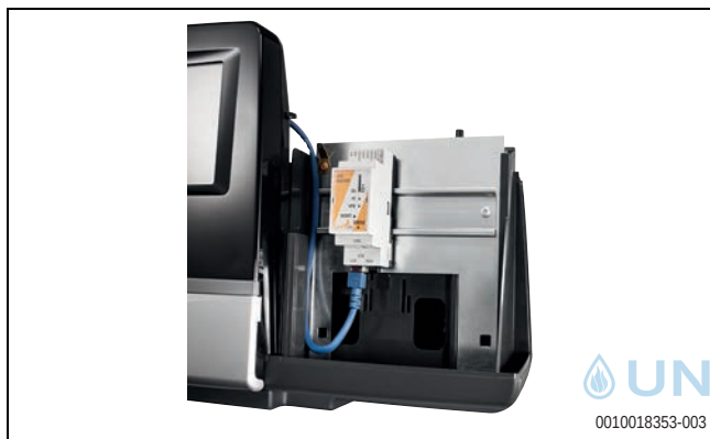
Bild 93 Montage von Bauteilen auf Hutschienenmodul
