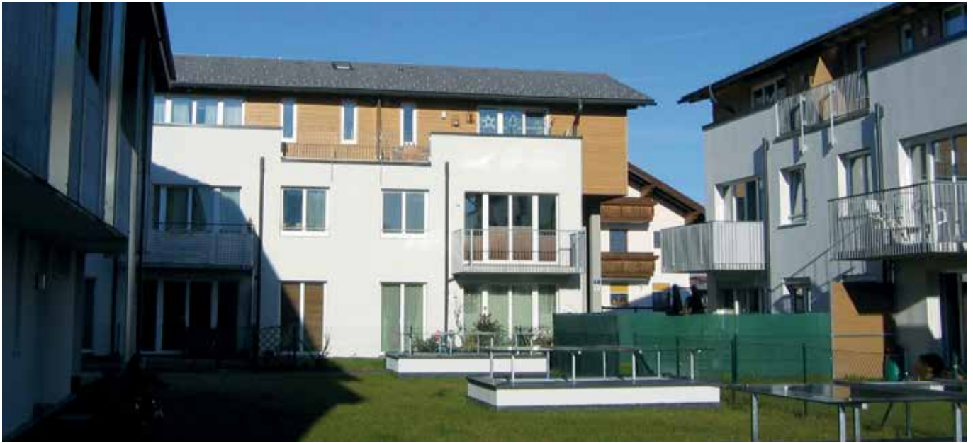
Walz (Österreich) – Mehrfamilienhäuser mit Fernwärme-Applikation
