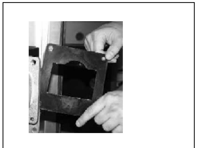
Bild: Gasgebläsedichtung entfernen
