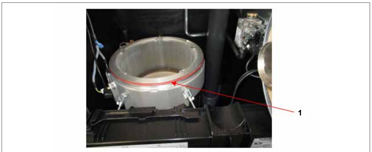
Abb. 5.21 Dichtring Brennkammerdeckel
