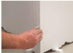
Beide Schürzenteile werden mit den beiliegenden Kunststoffnägeln zusammengesteckt.
