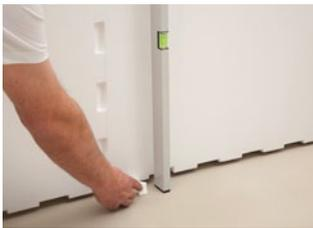
Für einen sicheren Sitz werden in den unteren Spalt Keile eingebracht. Der Sitz der Schürze wird mit einer Wasserwaage kontrolliert.
