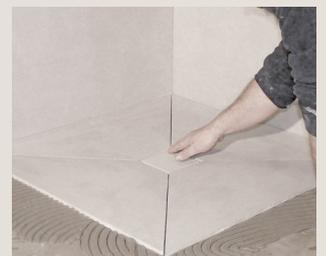
Durch die Dicke des Silikon-auftrags kann die Höhe justiert werden.
