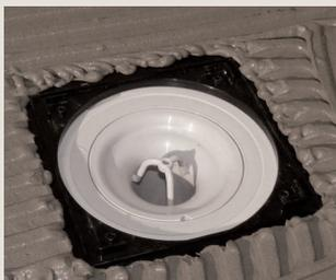
Der Fliesenkleber wird bis an die umlaufende Kante des Rahmens aufgetragen.
