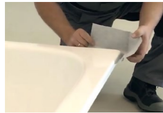
Nach dem Reinigen des Wannenrandes wird die 3D Dichtcke angesetzt und faltenfrei an den Wannenrand geklebt.
