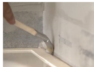
Die 5 mm breite Fuge wird ebenfalls mit Abdichtmasse ausgefüllt. Dazu wird am besten ein Pinsel verwendet.
