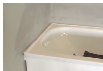
Danach ist die Wanne zuverlässig und dauerhaft angedichtet.
