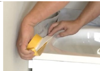
Das zweite Dämmband wird als Schutz-band oberseitig auf dem Wannenrand verklebt.
