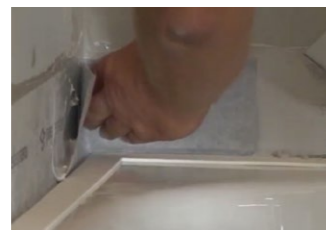
Die Abdichtmasse wird satt auf die Wände aufgetragen. Außerdem muss die Über-lappung zwischen dem Dichtband und der Dichtcke sorgfältig mit Abdichtmasse beschichtet werden. Dichtband und -ecke werden in die Abdichtmasse eingebettet.
