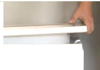
Danach wird die Wanne in den Wannen-träger gesetzt. Siehe auch Einbauan-leitung für den Poresta® Wannenträger.
