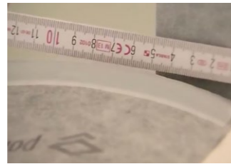
Die Überlappung mit der Dichtcke beträgt 5 cm.
