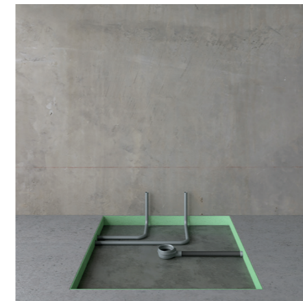
1. Einbringen der Randdämmstreifen und Anschluss des Dampfgenerators an den bauseits gestellten Elektroanschluss
