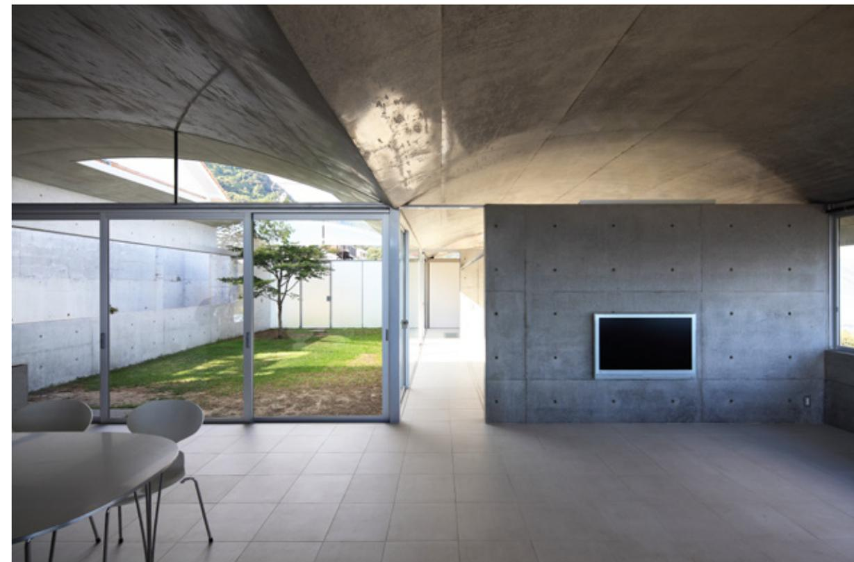
Die Wände in Fujimotos Sunami House sind allesamt unverputzt. Die kleinen Löcher sind Spuren der Abstandshalter, die bei den Betonarbeiten verwendet wurden.
