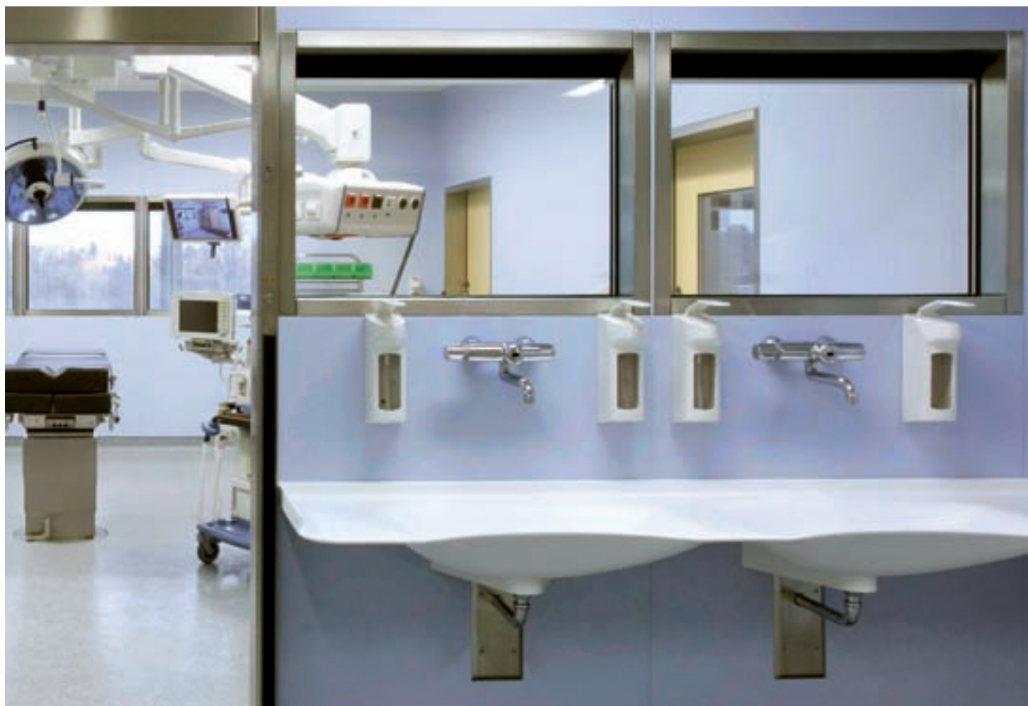
Erfüllt höchste Hygieneanforderungen: die GROHE Europlus E Thermostat-Waschtischbatterie mit Infrarotelektronik / Foto © Jochen Stüber, Hamburg
