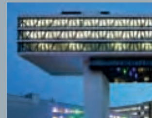
Medienbrücke München | Munich
