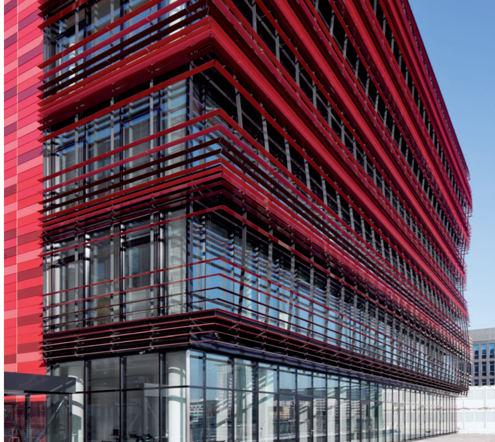
Das Fassadenfarbe changiert in fünf Stufen um ein klares Signalrot, jeweils um zwei Nuancen aufgehellt oder abgedunkelt
