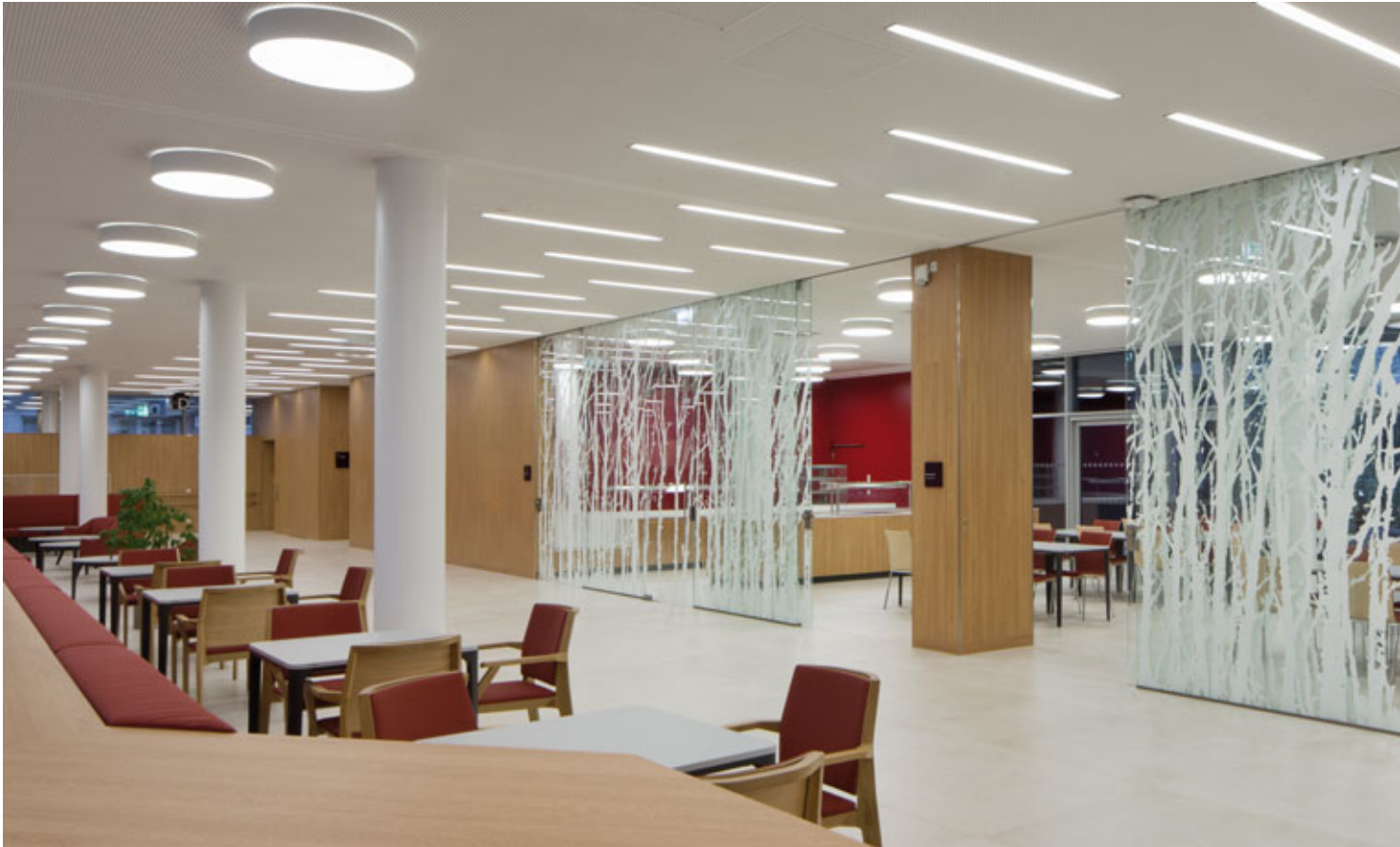
Altersgerechtes Lichtkonzept: Ältere Menschen sehen oft schlecht und benötigen eine höhere Beleuchtungsstärke von 500 Lux.
