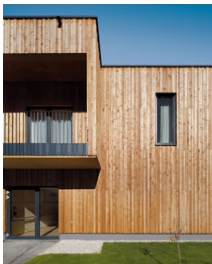
Die Fassade besteht aus Lärchenholz.
