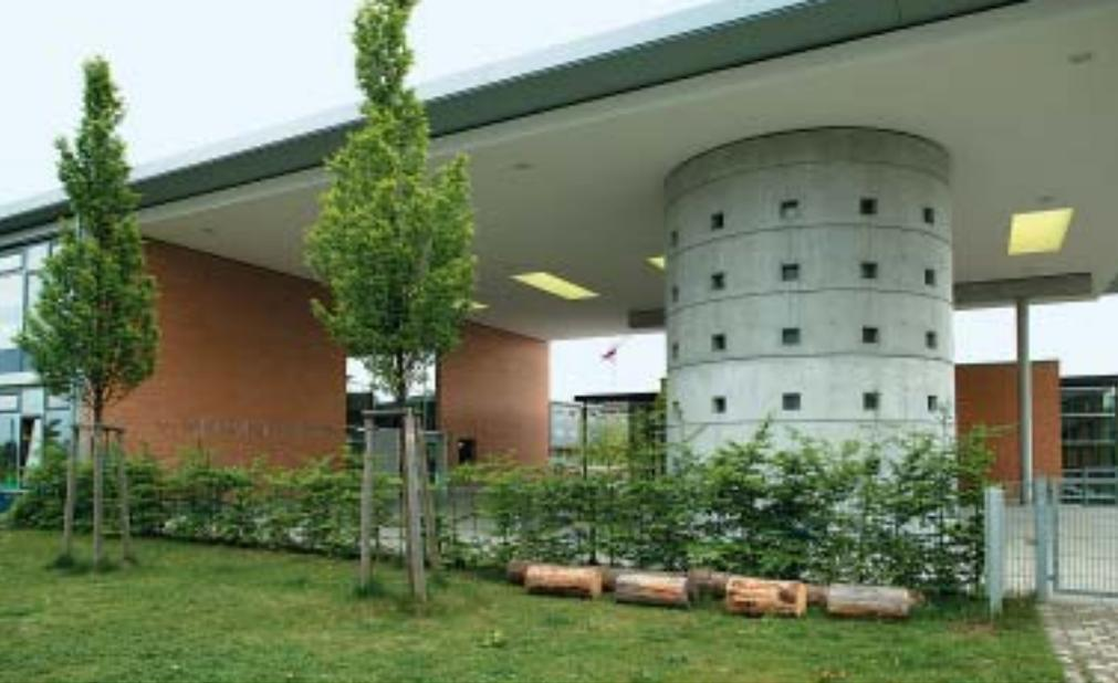
Der oberirdische Teil des Speichers wird von einem Betonzylinder eingefasst, dessen Glasbausteine nachts hinterleuchtet sind.
