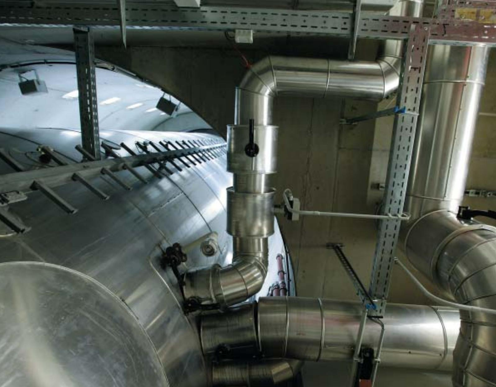
Unter dem Schulhof liegt die Heizzentrale, aus der sich ein gigantischer Solarpufferspeicher mit 90 cbm Volumen durch die Kellerdecke nach oben erstreckt.
