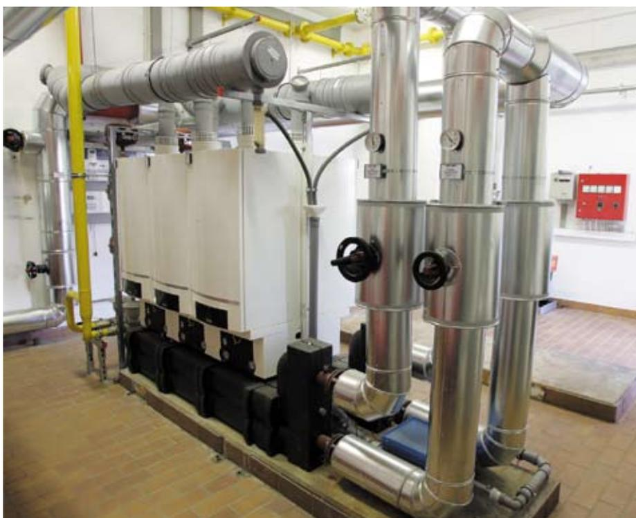
Wenig Platz und große Leistung – bei den Stadtwerken Hamm bringt eine Kaskadenlösung mit sechs Brennwertgeräten bis zu 600 kW Leistung.
