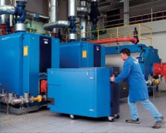
Die angebotenen Schalldämpfhauben sind üblicherweise nicht nur in Bezug auf die Geräuschemissionen, sondern auch hinsichtlich des Designs auf Brenner und Heizkessel abgestimmt.
