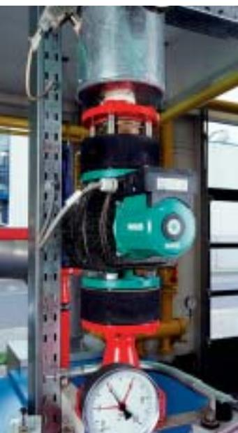
Kompensatoren z.B. in der Gasleitung und zwischen Umwälzpumpen im Rohrnetz verhindern die Ausbreitung von Körperschall.
