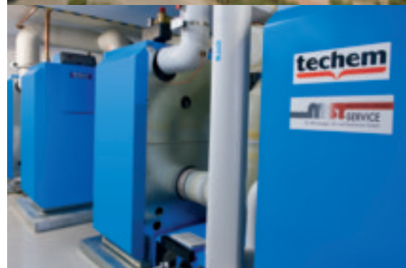
Mehrkesselschaltung mit Einbindung der Trinkwassererwärmung nach dem Legioex® Prinzip
