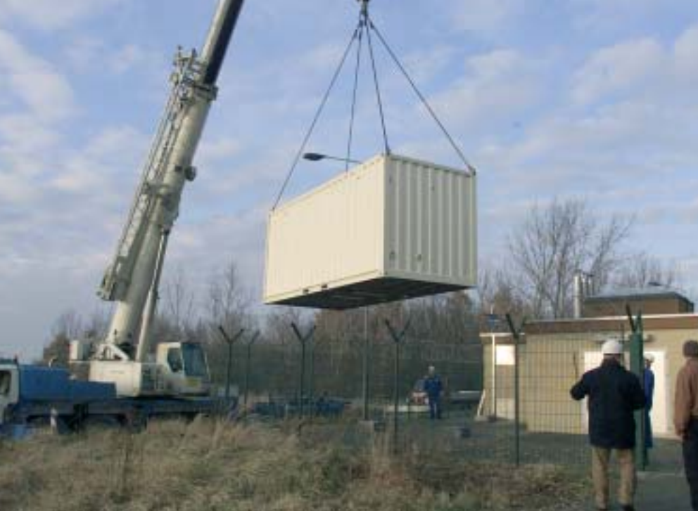
Energiezentrale am Haken: Der Energiecontainer für die Erdgas-Übergabestation kommt an seinen Bestimmungsort.
