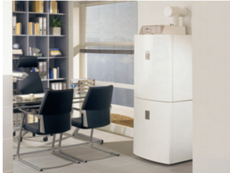
Öl-Kompaktheizkessel Logano plus GB135 mit Brennwertnutzung in raumluft- unabhängiger Betriebsweise
