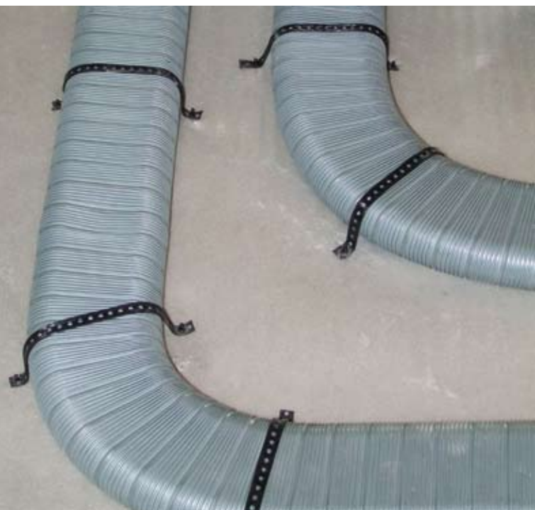
Der Name ist Programm , denn das Buderus Flexrohrsystem ZAS-B lässt sich auch in beengten Verhältnissen flexibel verlegen.
