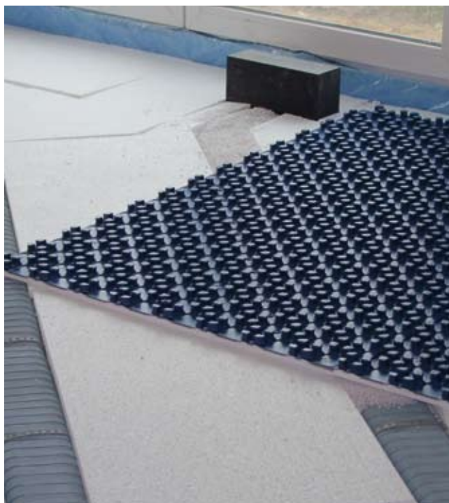
Das Buderus-Flachkanalsystem wurde im Fußbodenaufbau unter Estrich und Fußbodenheizung installiert.
