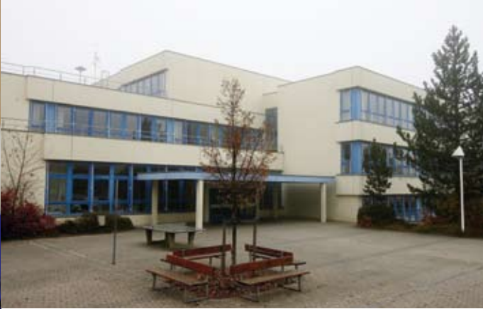
Die Hauptschule in Heilsbronn wurde saniert und energetisch aufgewertet. Eine Kaskade mit drei Gas-Brennwert-Wandheizkesseln Logamax plus GB162 liefert Wärme für die Klassenräume und eine Sporthalle.
