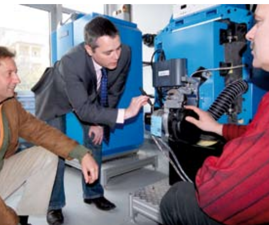
Die Schulung erfolgt praxisnah: Das in der Theorie erworbene Wissen kann direkt an den Heizkesseln angewendet werden.
